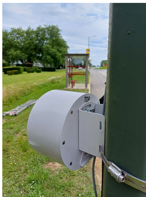
Stap 2: installatie van het koffertje met de batterij, de modem (of de SD-kaart lezer) en de zonneregelaar
