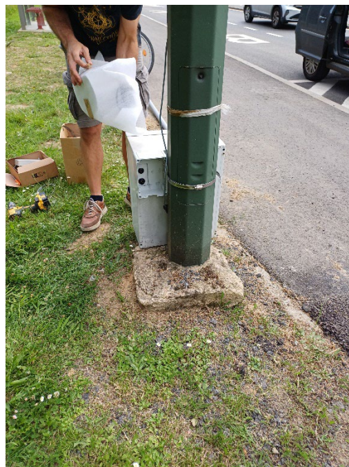
Stap 2: installatie van het koffertje met de batterij, de modem (of de SD-kaart lezer) en de zonneregelaar
