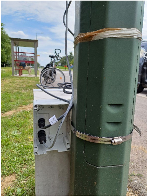
Stap 4: aansluiten van de 2 kabels
