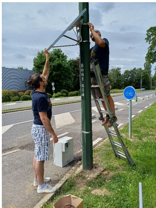
Stap 1: installatie van het zonnepaneel
