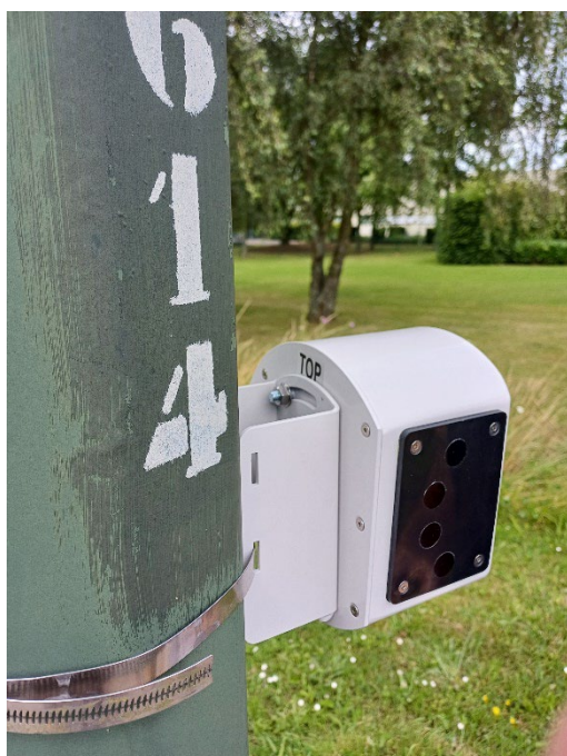
Stap 3: installatie van de TMA-3B3 sensor
